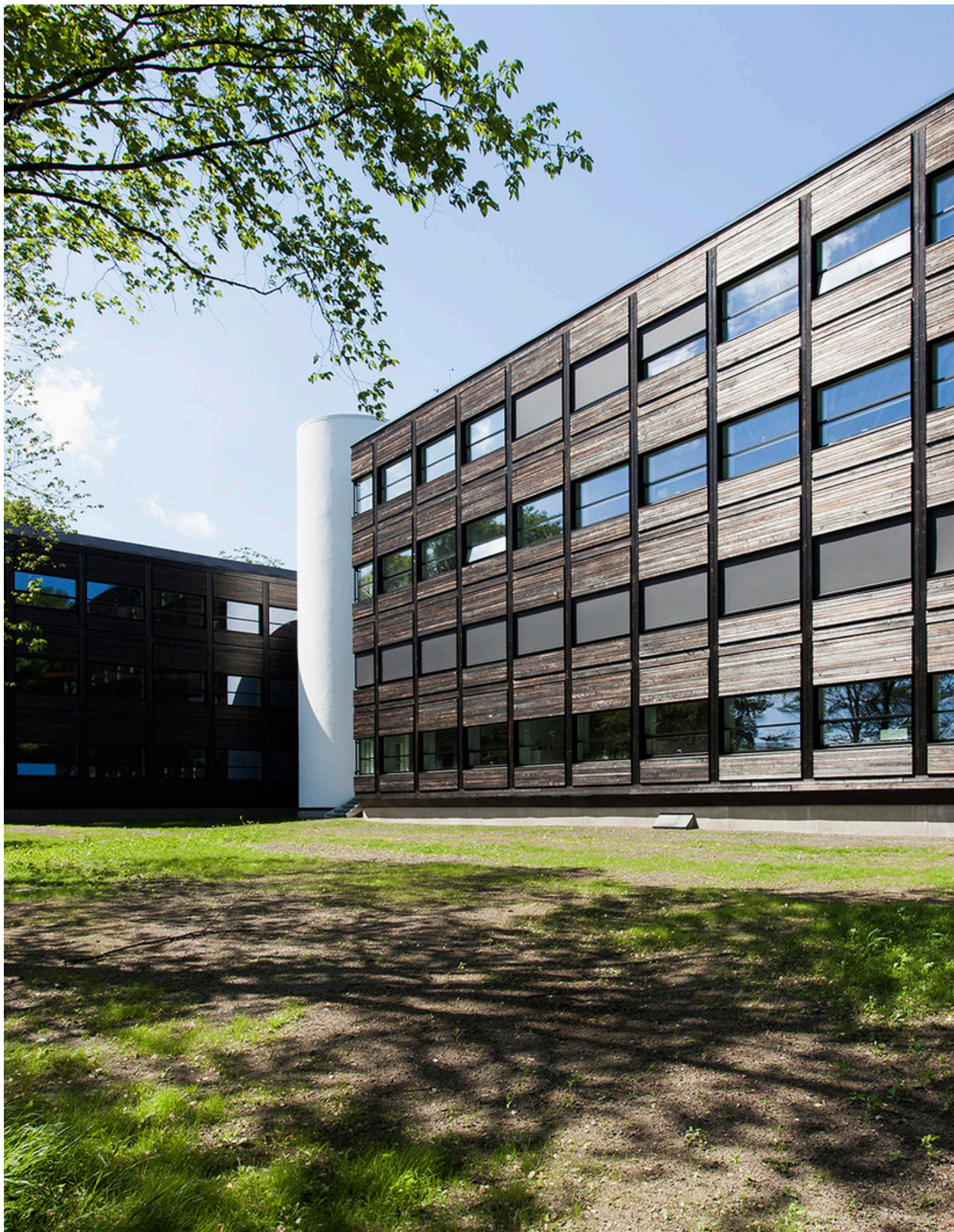
Powerhouse Kjørbo. Foto: Chris Aadland
